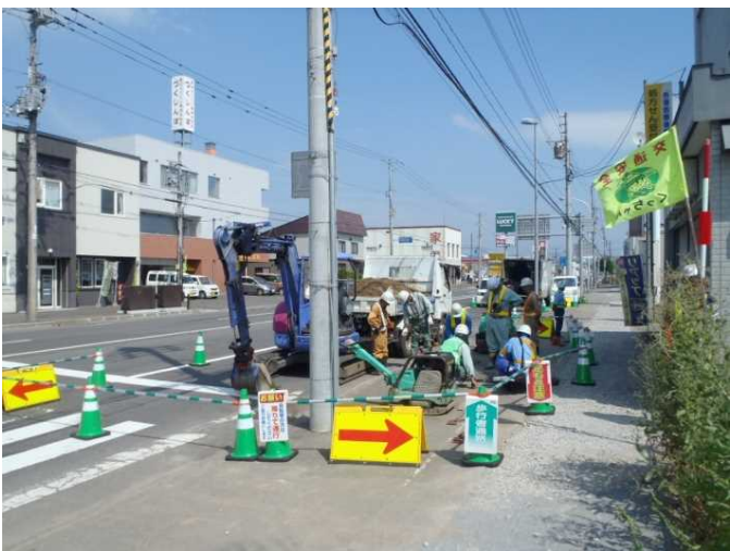
地下埋設物の試掘確認状況
