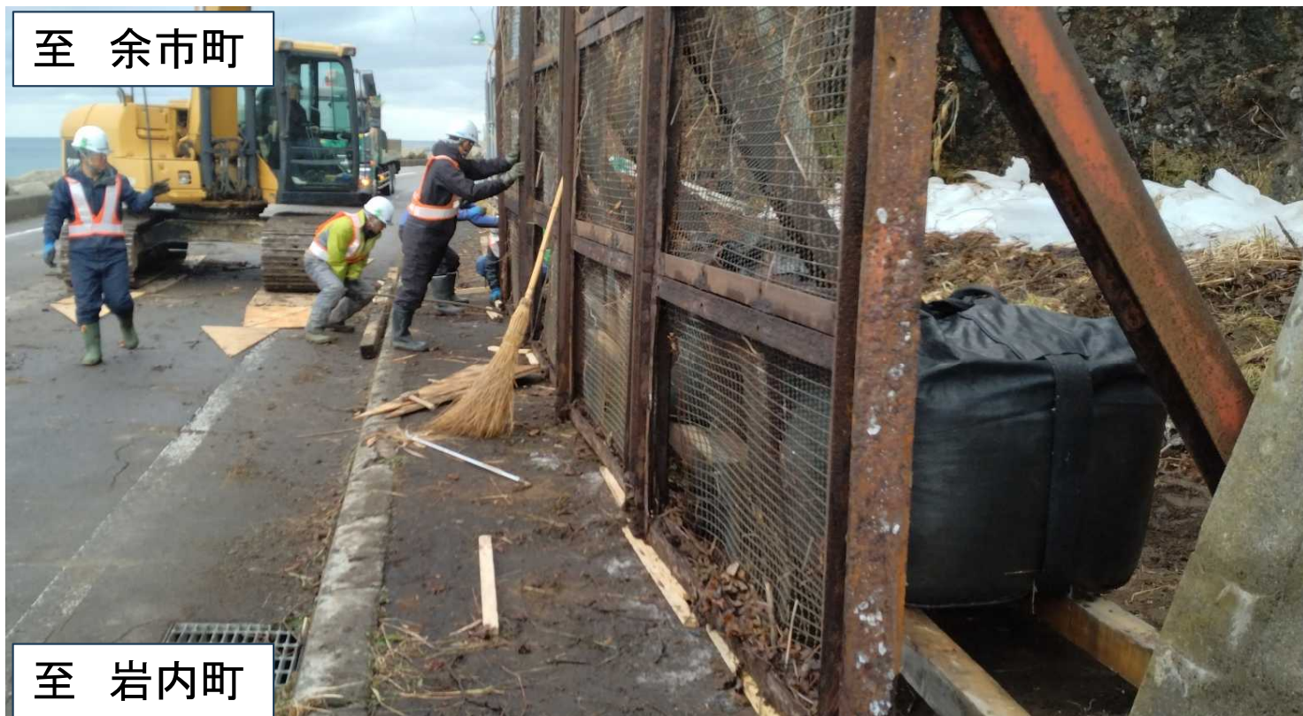
仮設落石防護柵の設置作業状況
