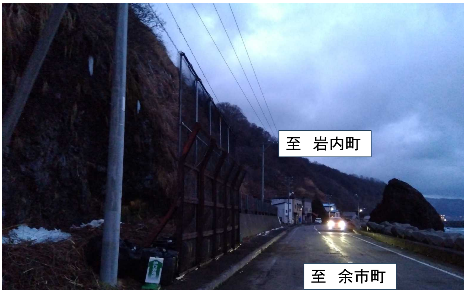
仮設落石防護柵の設置完了状況
