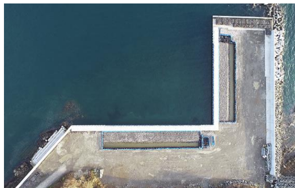
寿都地区 南ふ頭整備状況
