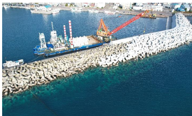
古平地区 東防波堤（改良）整備状況
