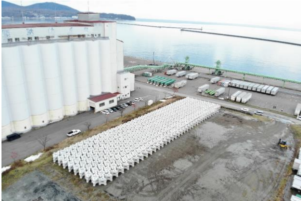
小樽港北副防波堤 整備状況
