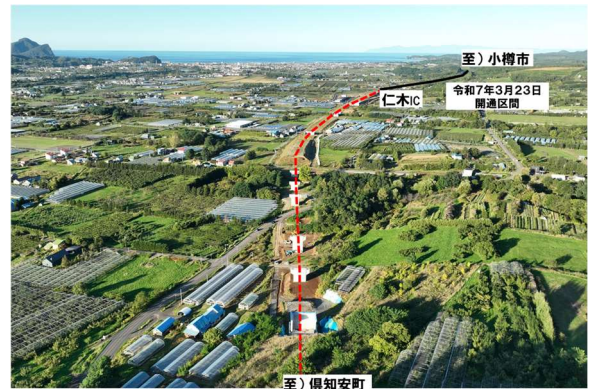
国道 5 号 倶知安余市道路（共和～余市） 仁木 IC 付近
