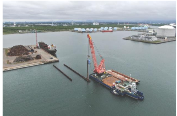
石狩湾新港水深 12m 岸壁 整備状況
