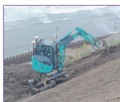
位置情報で管理された高所法面掘削機による施工
