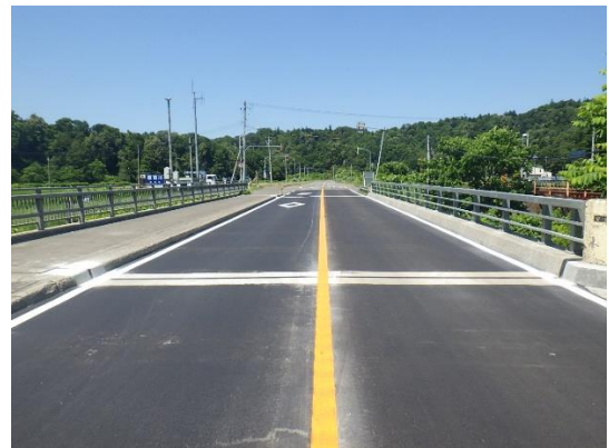
【橋梁補修後（伸縮装置）】
