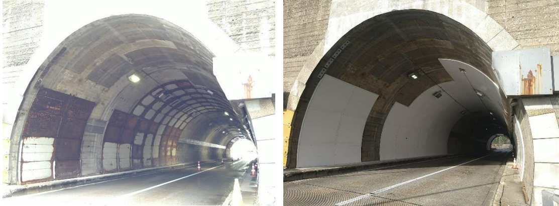
【道路トンネル補修】
