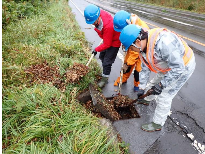
【排水構造物清掃】
