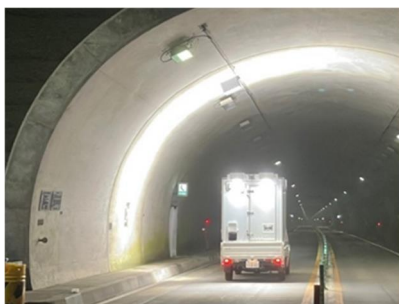
画像計測技術による覆工撮影
