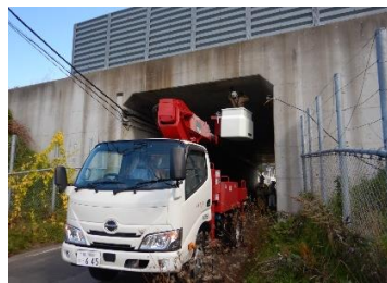
【大型カルバート点検】
