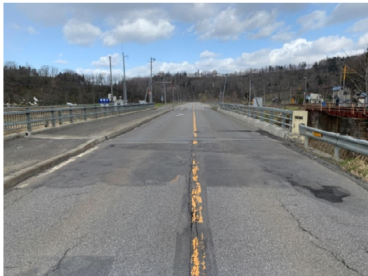
【橋梁補修前（伸縮装置）】
