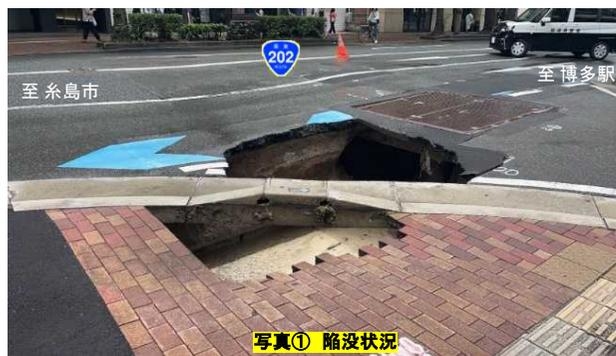
写真① 陥没状況
