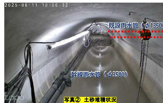
写真② 土砂堆積状況
