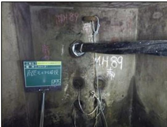
点検状況（マンホール壁面モルタル剥離確認）
