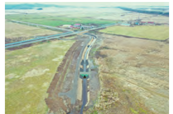
(産土地区 11号排水路施工後)
