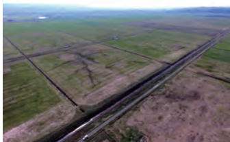
(産土地区 暗渠施工前)
