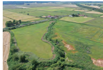
(産土地区 11号排水路施工前)
