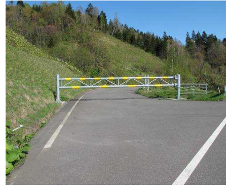
ゲート1(進入道路1)
