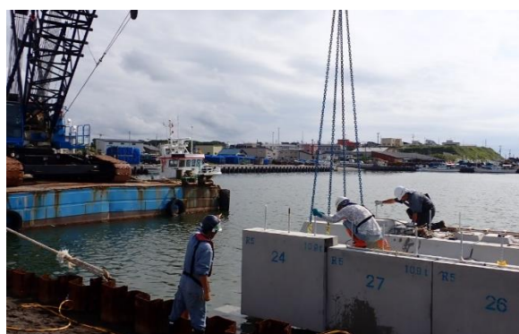
水深4m物揚場の本体工据付状況
