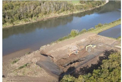
河道掘削(天塩川)
