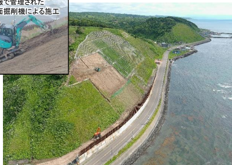
道路斜面の防災対策（ICT施工の導入） （苫前町力屋）
