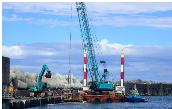
南防波堤の本体工コンクリート打設状況
