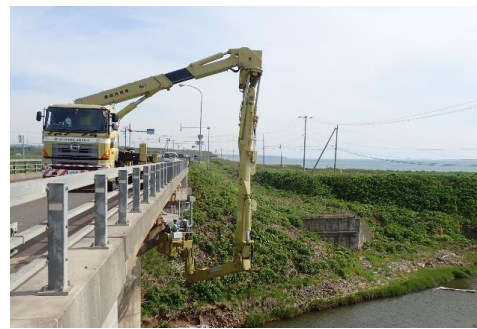
橋梁点検（国道232号旭橋）
