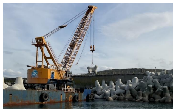
北防波護岸の消波ブロック据付状況
