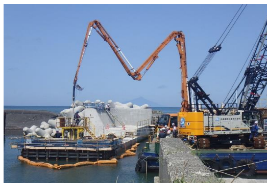
南防波堤水中コンクリート打設状況
