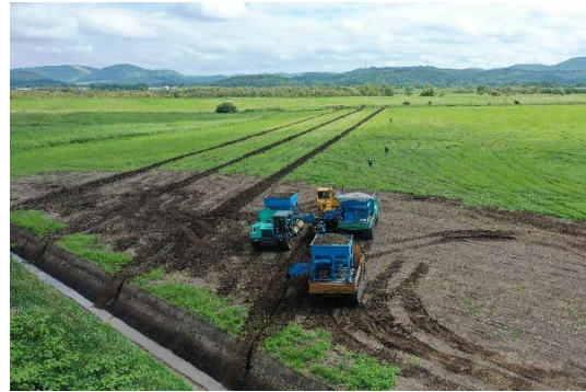
産土地区の暗渠排水施工状況
