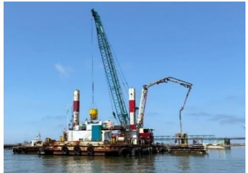
導流堤改築(留萌川)
