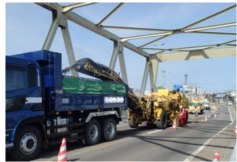
橋梁修繕（国道231号港栄橋）
