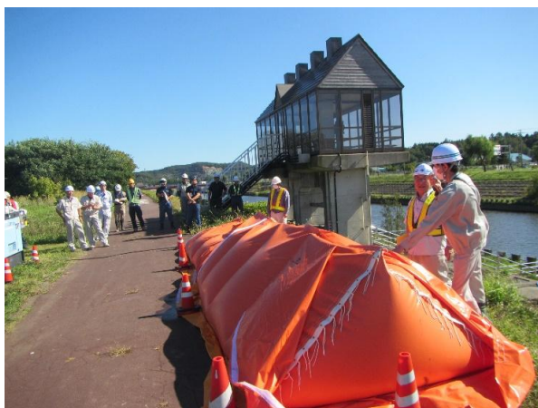
水防工法(水マット工)実施状況
