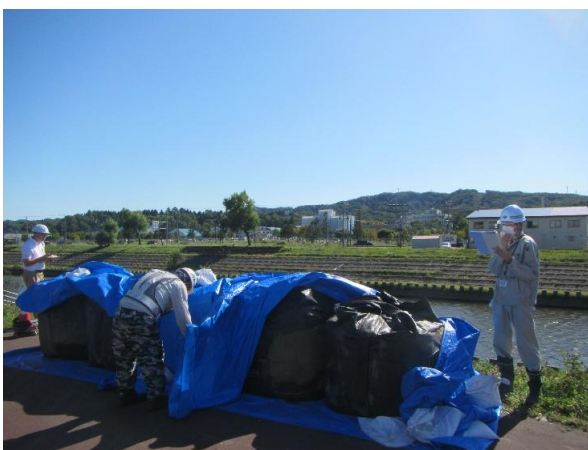
水防工法(大型土のう工)実施状況
