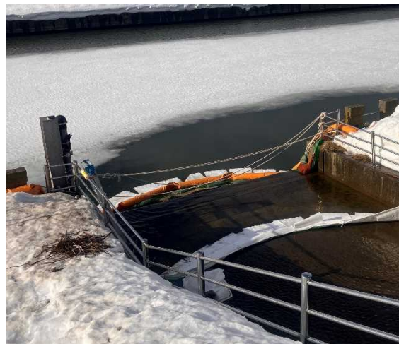
写真5 留萌川合流付近 オイルフェンス・オイルマットの設置状況
