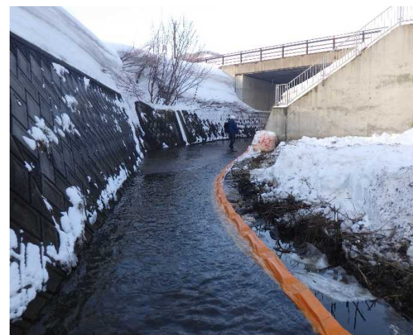
写真6 カモイワ川オイルフェンス 設置状況
