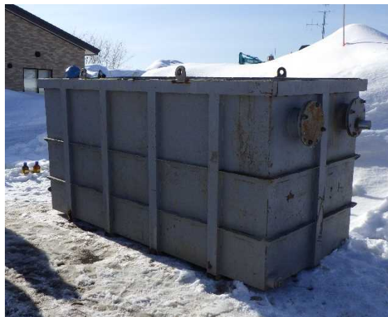
写真2 油分離槽の設置状況
