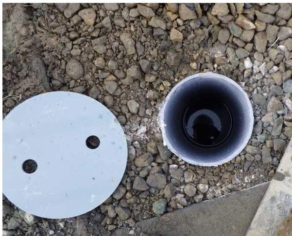
写真4 注水井の設置状況
