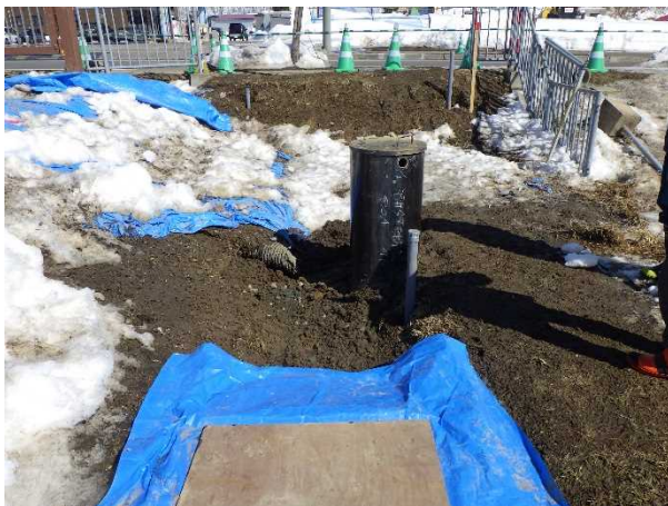
写真1 揚水井の設置状況
