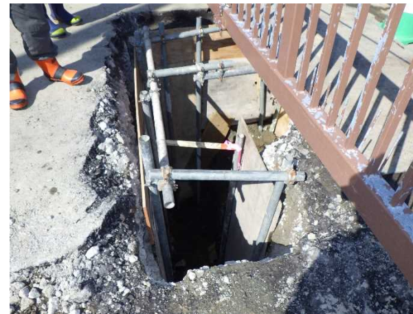
写真3 釜場の設置状況 (転落防止のため鉄板等設置します)
