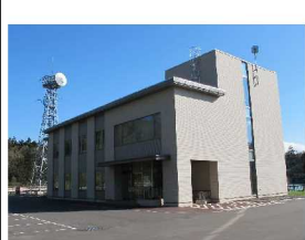
留萌ダム管理支所
