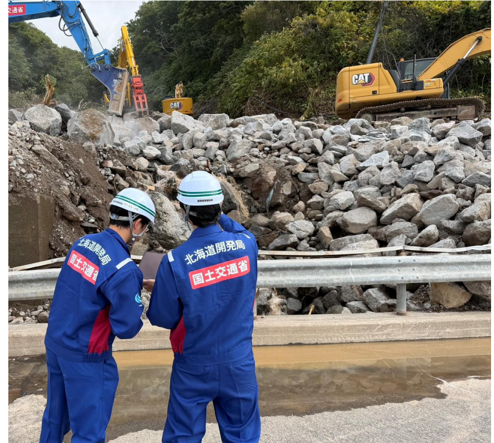
上流側岩塊堆積状況
