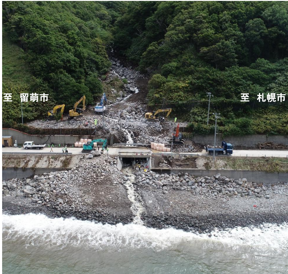
上流側岩塊除去作業
