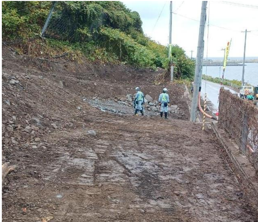
上流側の岩塊撤去完了状況
