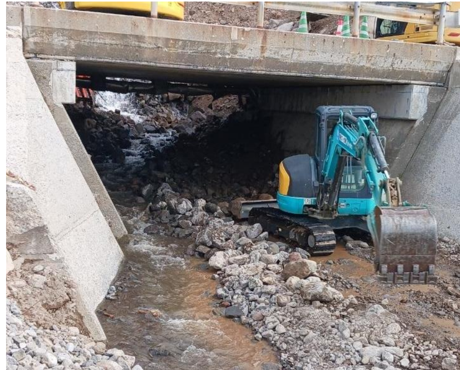
橋梁下の岩塊撤去状況
