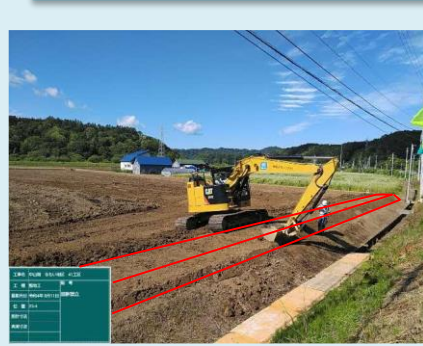
農業用排水路の施工状況
