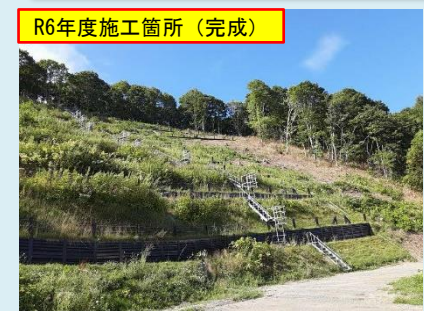
急傾斜地崩壊対策施設
