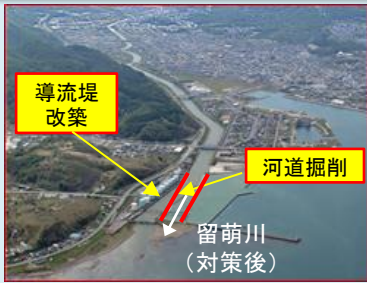
導流堤改築の実施状況
