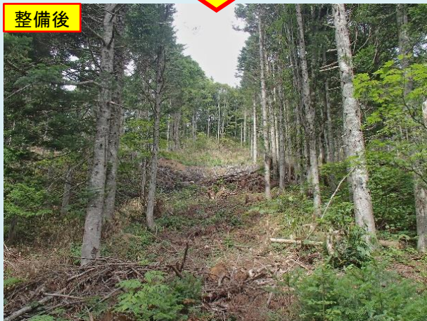
伐採作業による森林整備の実施状況
