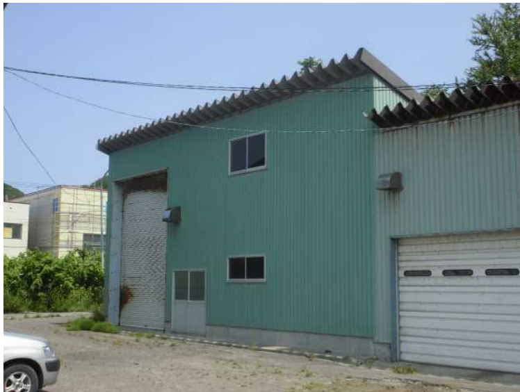
水防資材の保管倉庫 (留萌建設管理部事業課)
