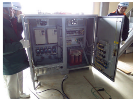
ポンプパッケージ （制御盤側）内部
