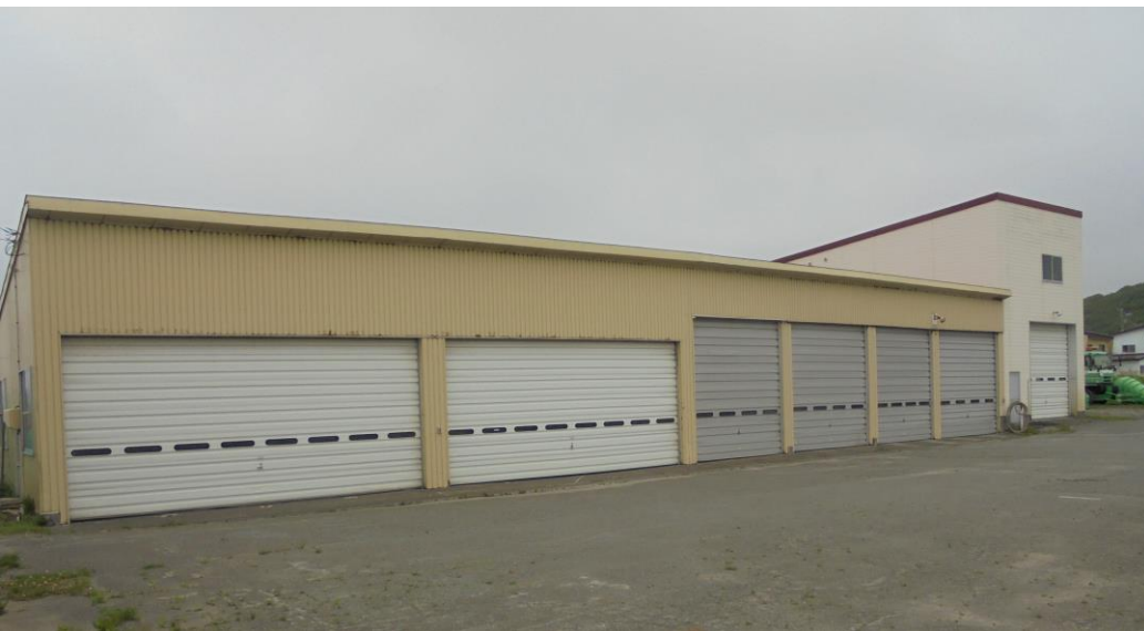
水防資材の保管倉庫 (稚内建設管理部事業課)
