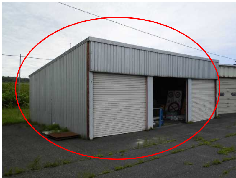
水防資材の保管倉庫 (留萌建設管理部遠別出張所)
