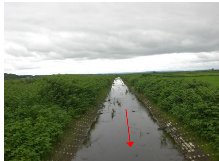
H28清明川道単改修工事
