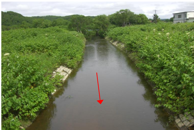
H28福永川道単改修工事
