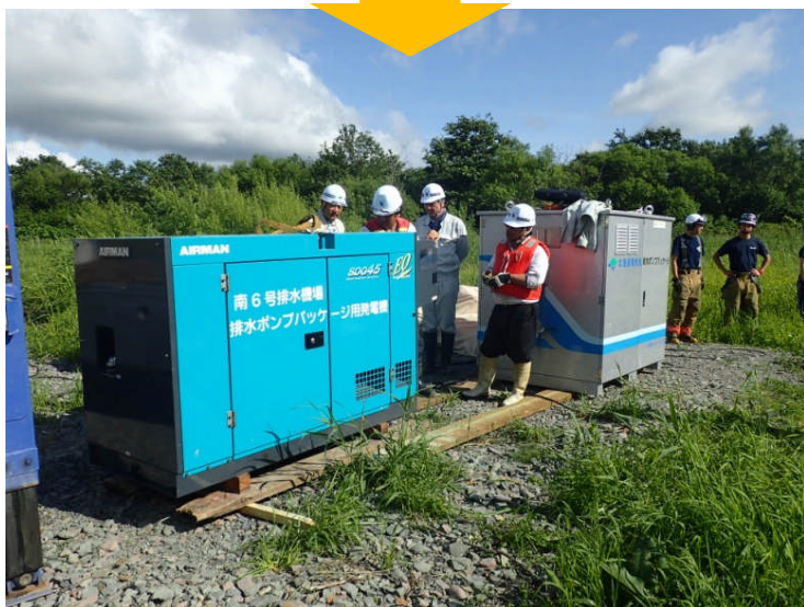
排水ポンプの設置状況
