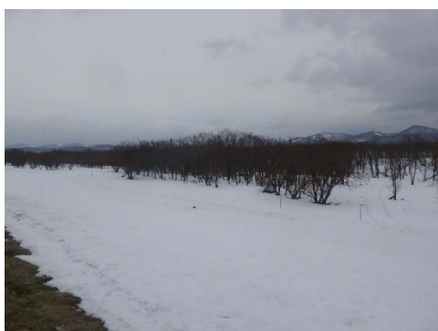
高水敷間引伐開 施工前
