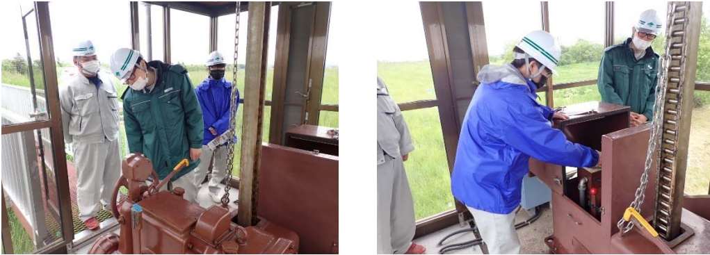
樋門動作設備点検状況
