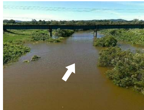
出水後点検状況（問寒橋）
