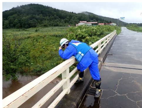
出水時巡視状況
