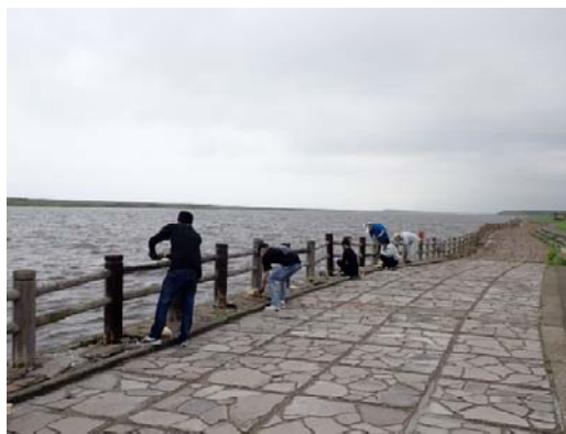
柵の補修(塗装)
