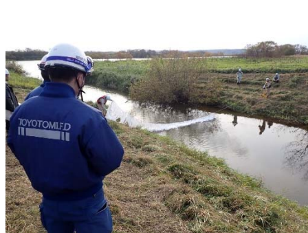
オイルブロッカー設置状況
