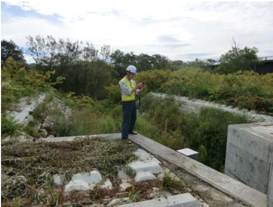
樋門巡視状況
