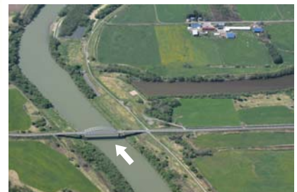
天塩川下流 新問寒別橋付近
