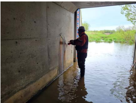
河川管理施設(樋門)点検
