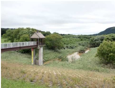
出水後点検状況（辰根牛樋門）
