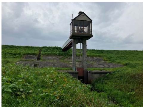
振老4号樋門 施工前
