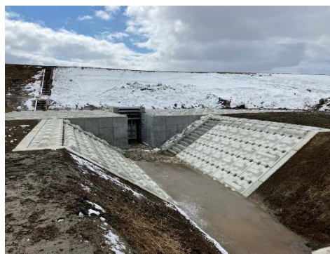
振老4号樋門 施工後
