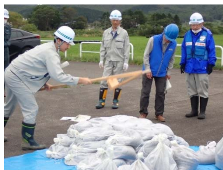
改良積み土のう実演
