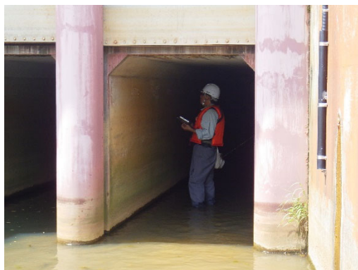
構造物の確認
