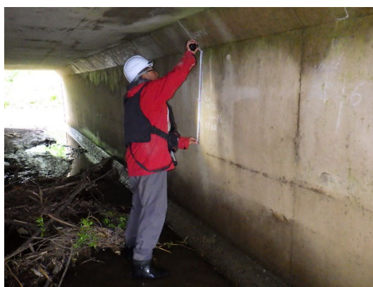
樋門点検の状況
