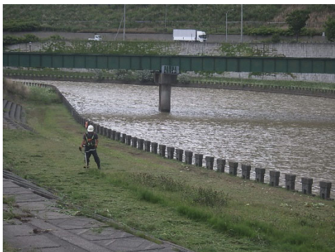
人力による堤防除草
