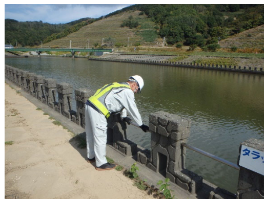
安全防止柵の点検
