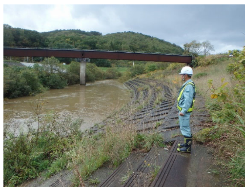
河道点検状況
