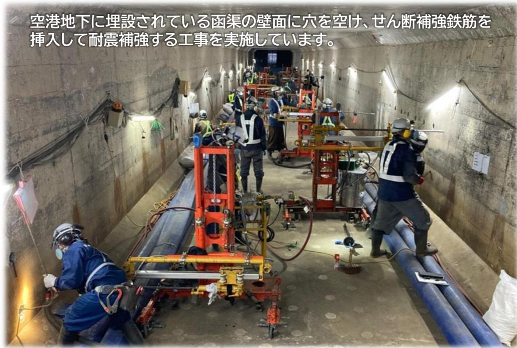
【美沢川函渠耐震補強 施工状況】
