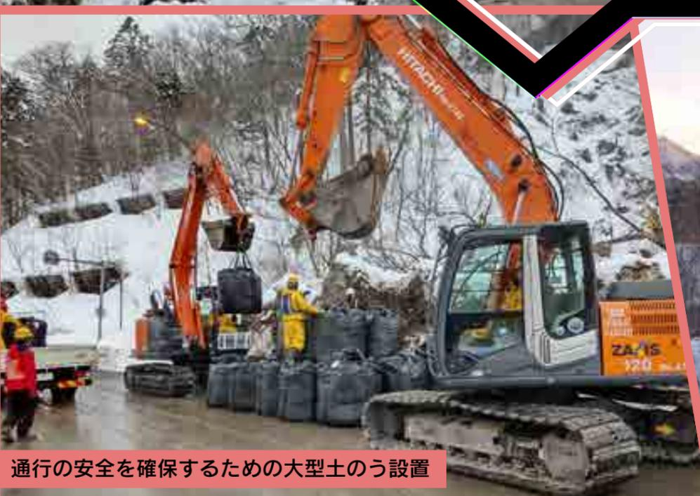
通行の安全を確保するための大型土のう設置
