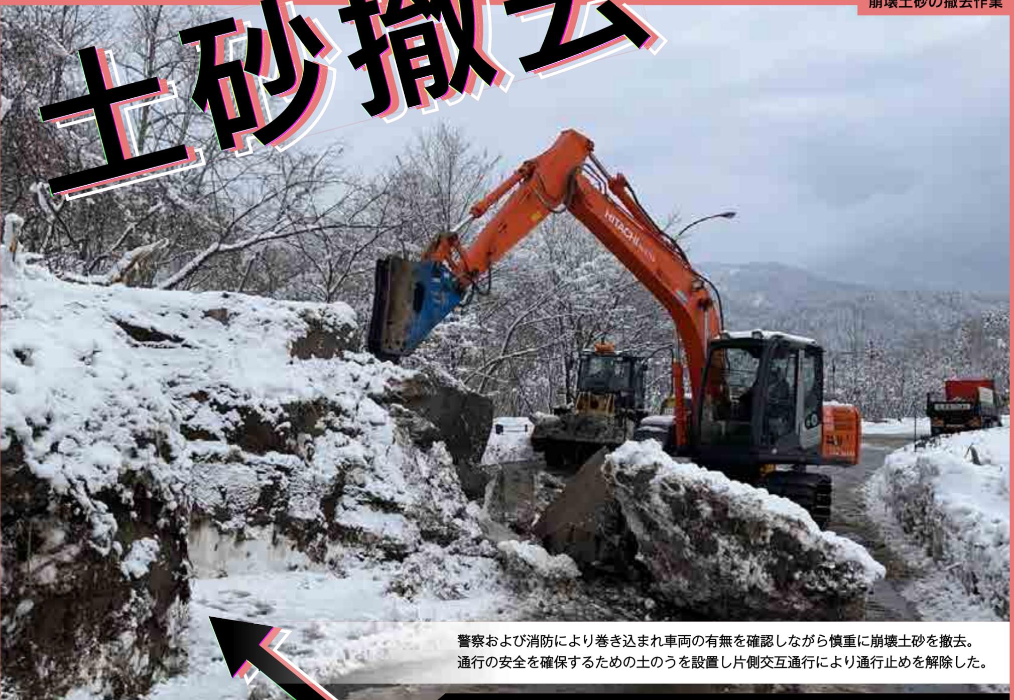
警察および消防により巻き込まれ車両の有無を確認しながら慎重に崩壊土砂を撤去。通行の安全を確保するための土のうを設置し片側交互通行により通行止めを解除した。
