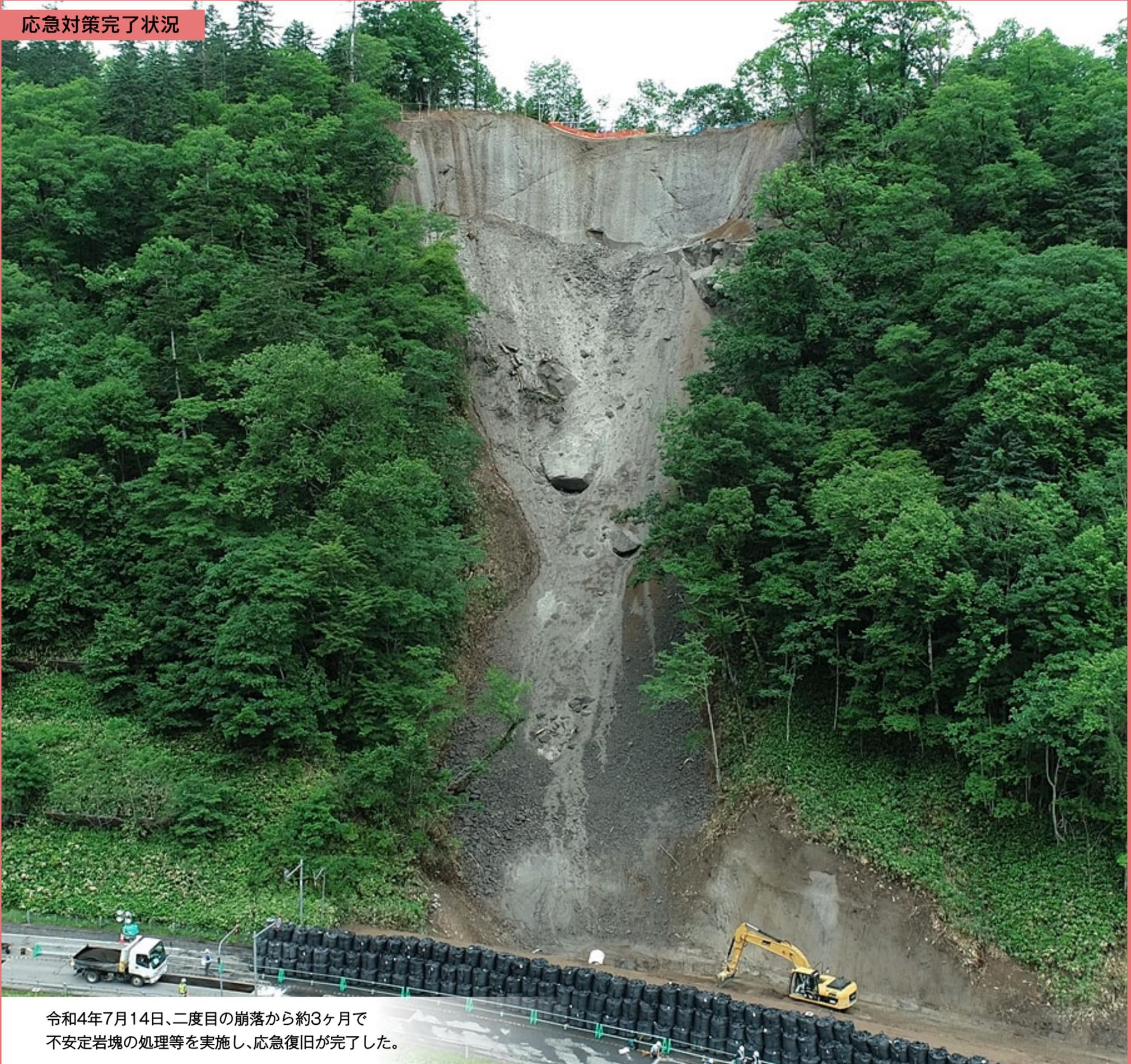
令和4年7月14日、二度目の崩落から約3ヶ月で不安定岩塊の処理等を実施し、応急復旧が完了した。
