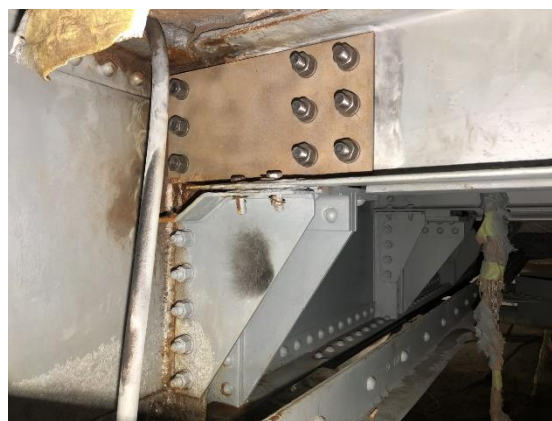
【橋梁補修後（当て板補強）】
