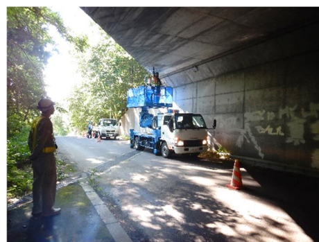
【大型カルバート点検】
