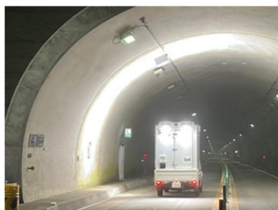
画像計測技術による覆工撮影
