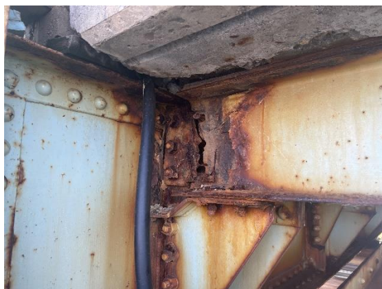
【橋梁補修前（当て板補強）】
