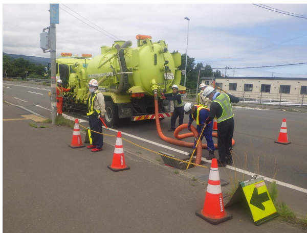
【排水構造物清掃】
