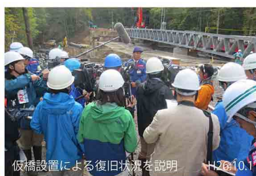
仮橋設置による復旧状況を説明
