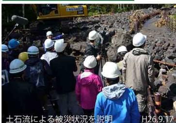
土石流による被災状況を説明
