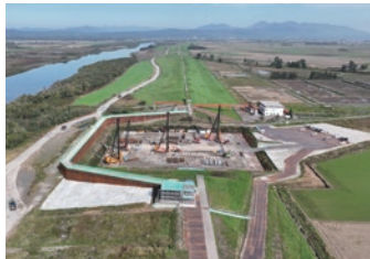
整備が進む北村遊水地(排水門)
