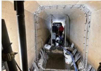
樋門継手部分の補修メンテナンス
