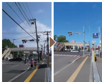
無電柱化整備の状況(国道12号)
