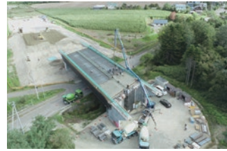
道央圏連絡道路
