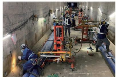
耐震補強による地下構造物の崩壊防止
