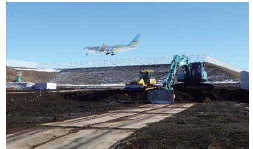
RESA盛土整備状況
