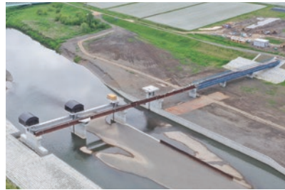
頭首工整備(雨竜川下流地区)
