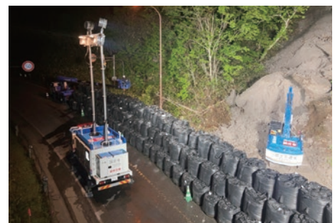
土砂除去状況(遠隔操作機械、照明車)(国道276号美笛峠)
