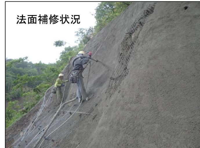
風化した泥岩等が分布している切土工事の法面对策工を増
