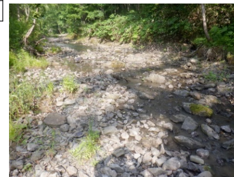
減水区間の状況(石桂下5)
