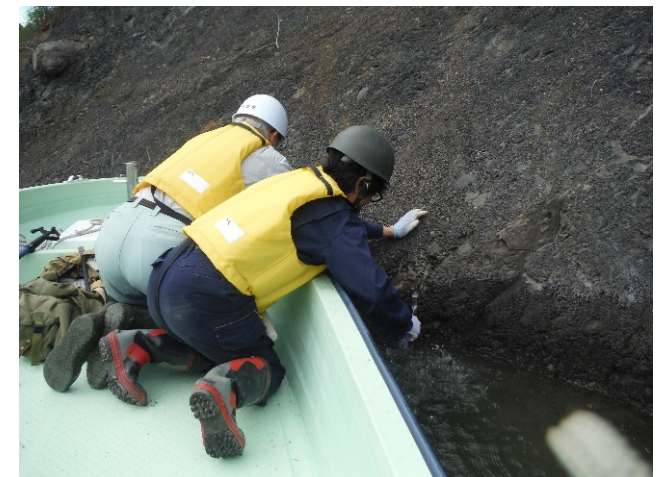
湖岸部巡視状況
