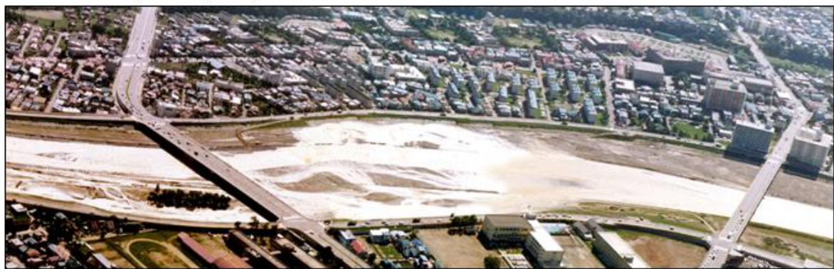
南19条橋～南22条橋の堆砂状況
