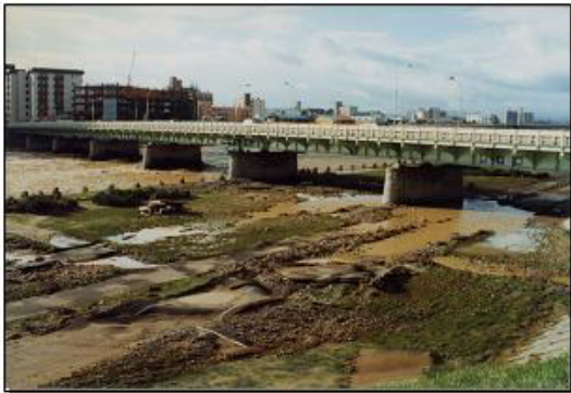
幌平橋（当時）左岸下流
