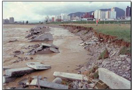
南大橋左岸下流
