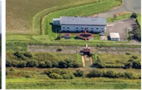
排水機場の排水規制緩和
