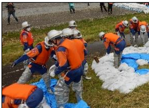
漏水対策工法(月の輪工)
