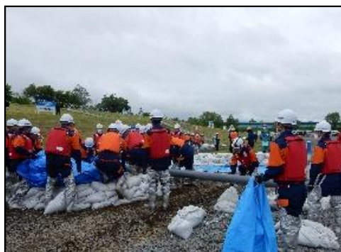
漏水対策工法(釜段工)
