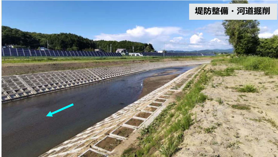
雨煙別川 施工済み箇所
