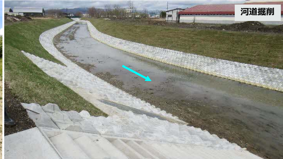
利根別川 施工済み箇所
