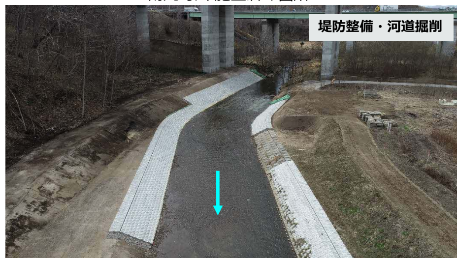
島松川 施工済み箇所
