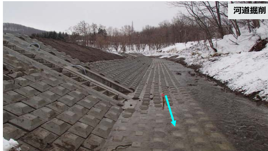
石山川 施工済み箇所
