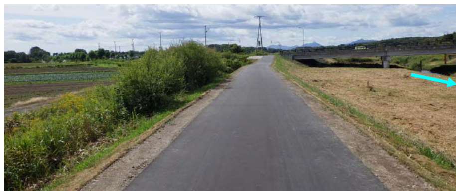
島松川 施工済み箇所
