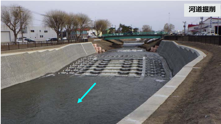
月寒川 施工済み箇所
