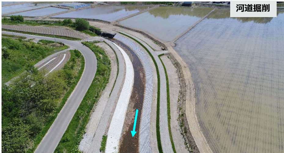
阿野呂川 施工済み箇所
