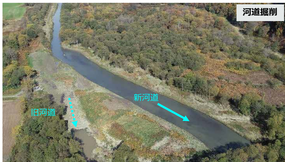
雨竜川 施工済み箇所
