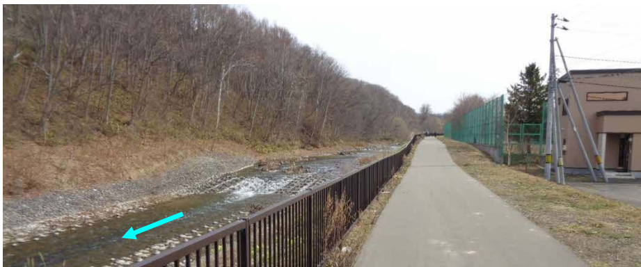
真駒内川 施工済み箇所
