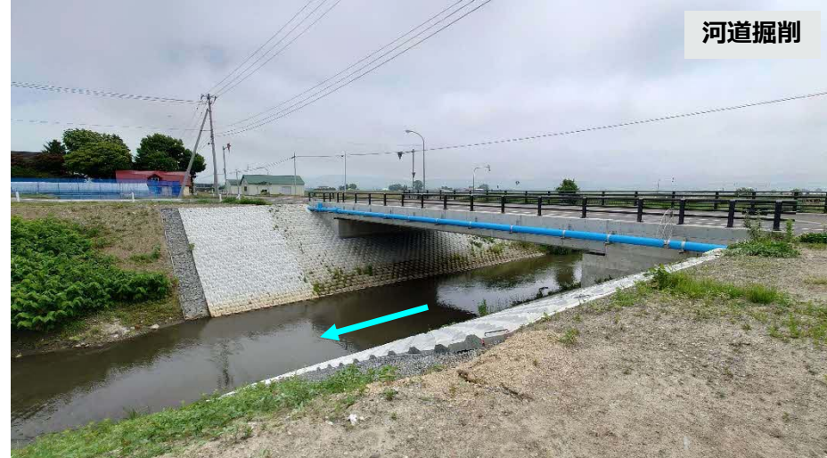
南九号川 施工済み箇所
