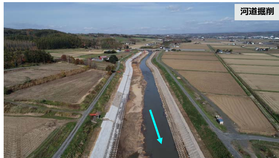
富良野川 施工済み箇所
