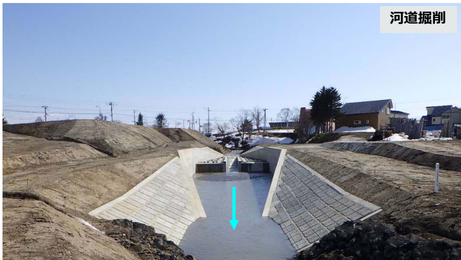
ラウネ川 施工済み箇所
