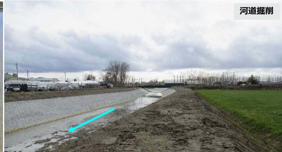
利根別川 施工済み箇所
