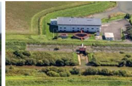
排水機場の排水規制緩和
