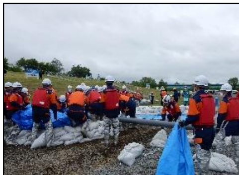
漏水対策工法(釜段工)
