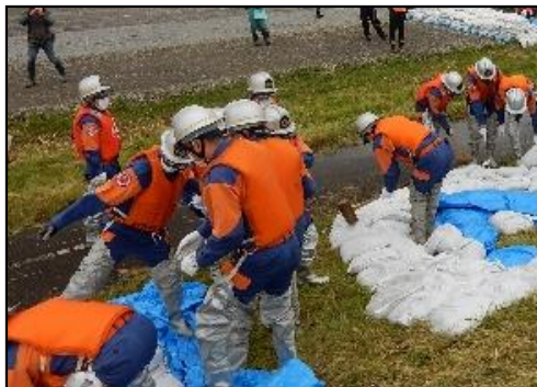
漏水対策工法(月の輪工)
