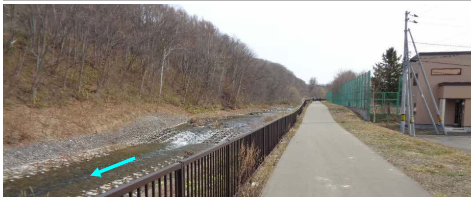
真駒内川 施工済み箇所
