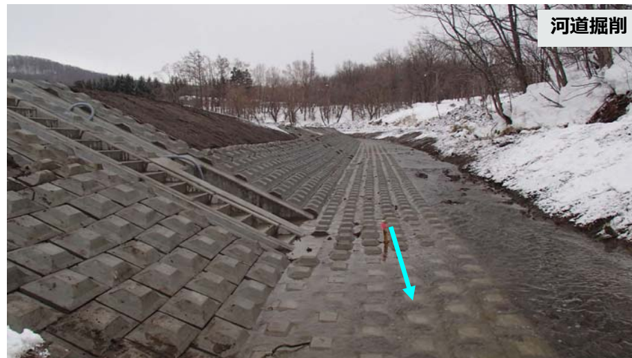
石山川 施工済み箇所
