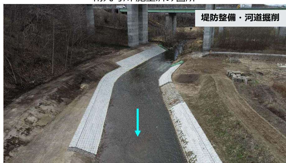
島松川 施工済み箇所
