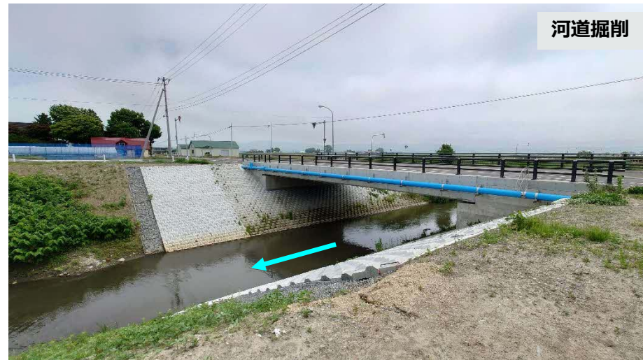
南九号川 施工済み箇所
