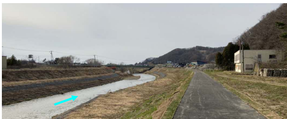
雨煙別川 施工済み箇所
