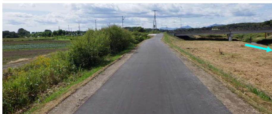
島松川 施工済み箇所
