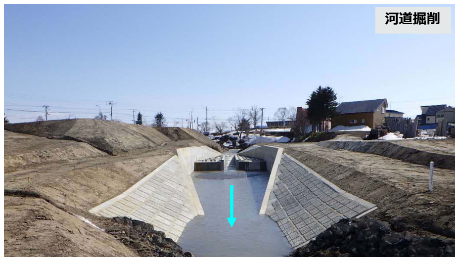
ラウネ川 施工済み箇所
