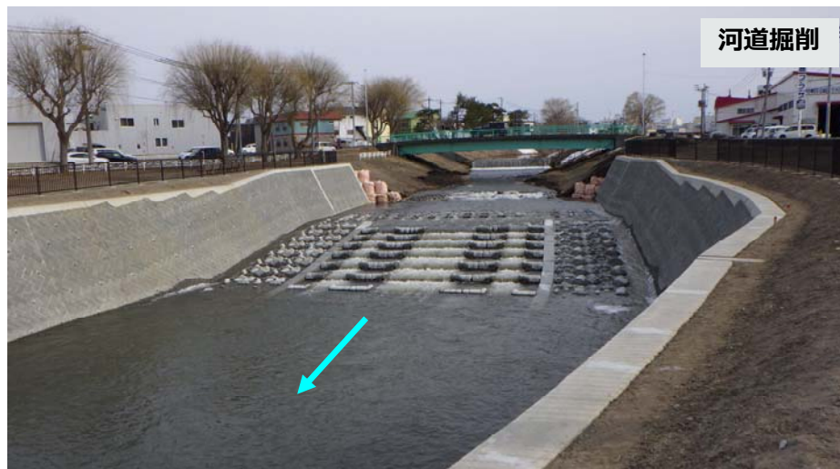
月寒川 施工済み箇所
