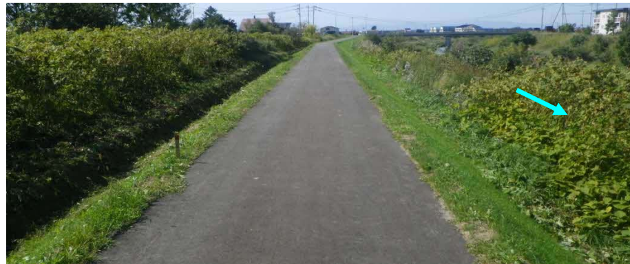
利根別川 施工済み箇所
