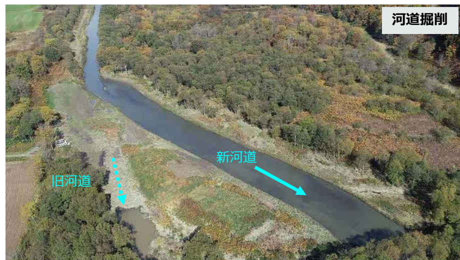
雨竜川 施工済み箇所
