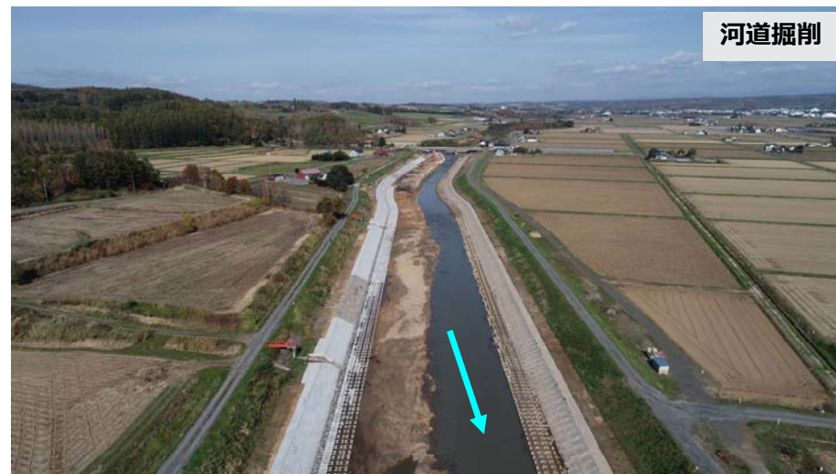
富良野川 施工済み箇所
