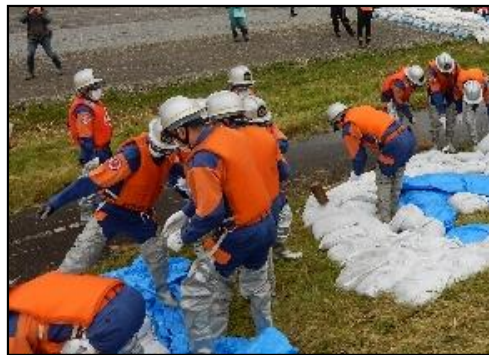
漏水対策工法(月の輪工)
