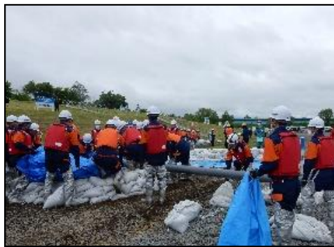
漏水対策工法(釜段工)
