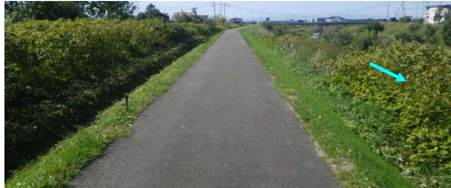
利根別川 施工済み箇所
