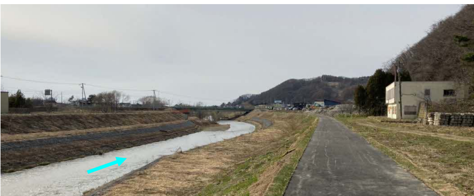
雨煙別川 施工済み箇所
