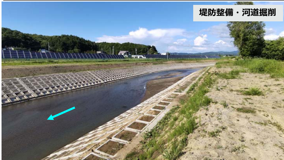
雨煙別川 施工済み箇所
