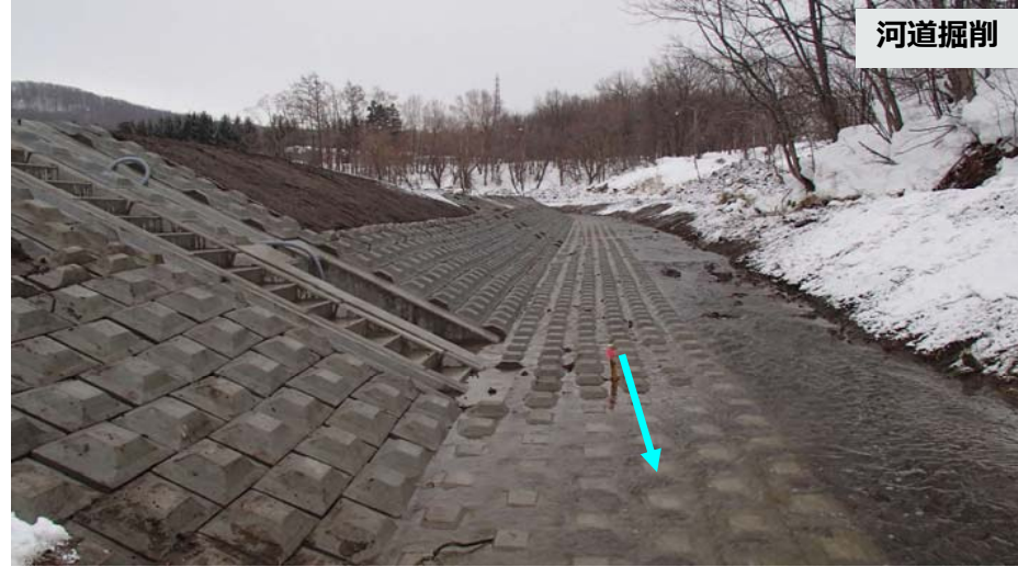
石山川 施工済み箇所
