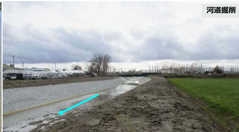
利根別川 施工済み箇所
