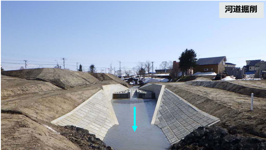
ラウネ川 施工済み箇所
