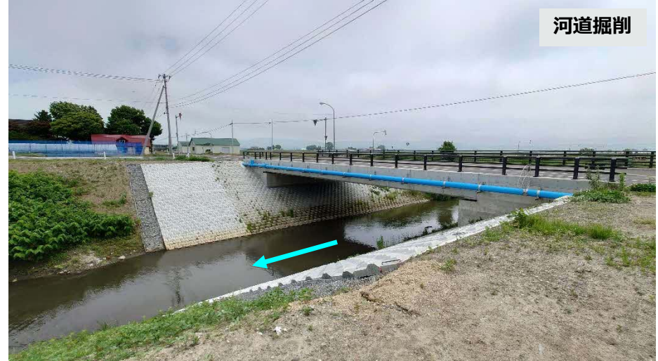
南九号川 施工済み箇所
