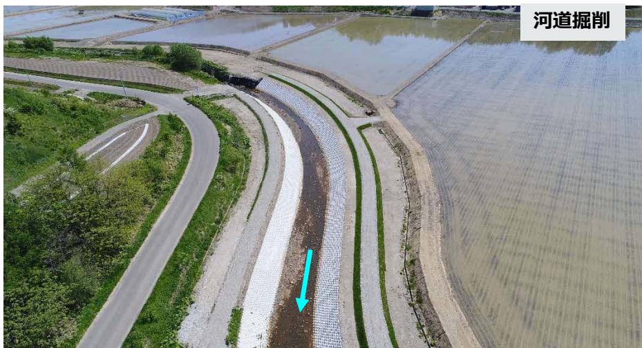
阿野呂川 施工済み箇所
