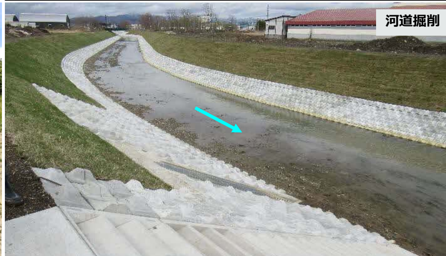
利根別川 施工済み箇所
