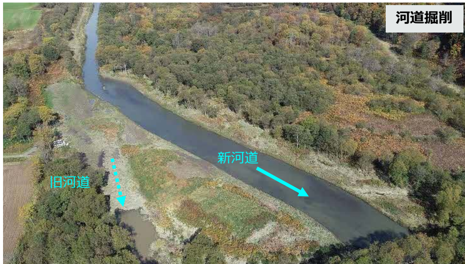
雨竜川 施工済み箇所
