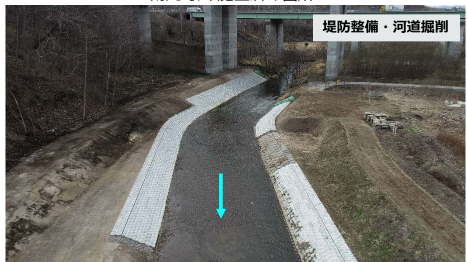
島松川 施工済み箇所
