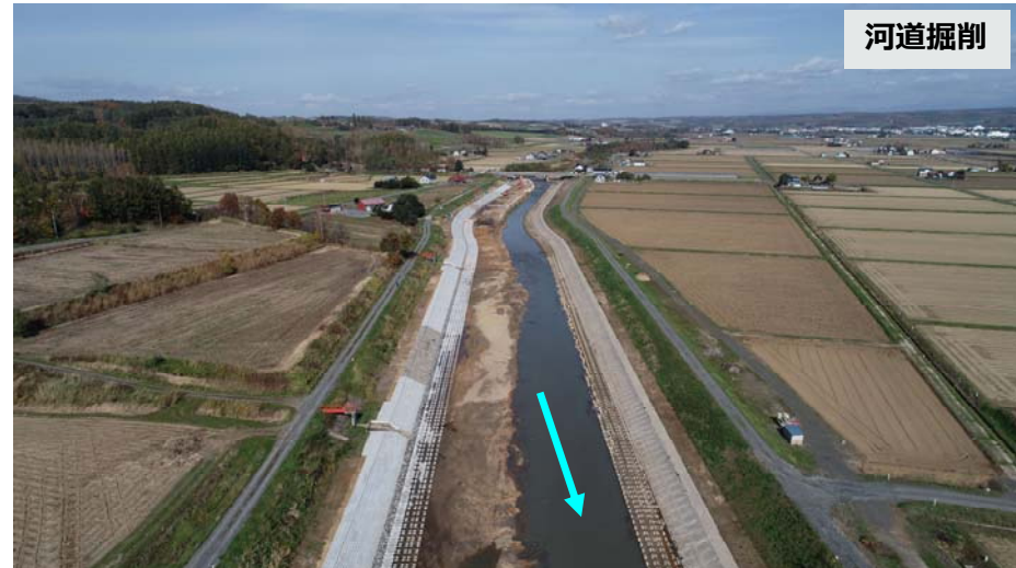
富良野川 施工済み箇所
