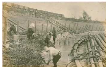
当時の岡崎式単床ブロックの施工状況
