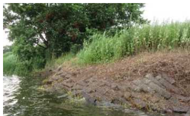
茨戸川に現存する 岡崎式単床ブロック護岸 (大正6年度完成石狩市生振)
