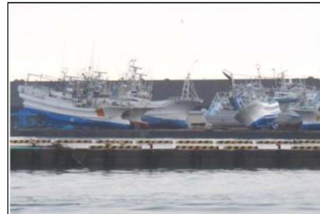
十勝港 (津波による漁船の被害状況)
