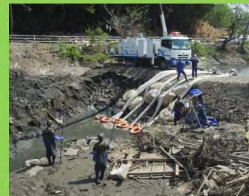
排水ポンプ車による排水
