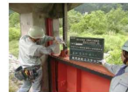
樋管ゲートの点検
