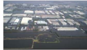
ロジャナ工業団地(タイ)の 工場建屋の水没の様子
