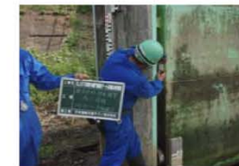
ゲート設備の点検・整備
