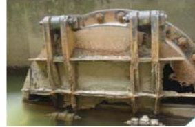
ポンプ設備の逆流防止弁の破損状況
