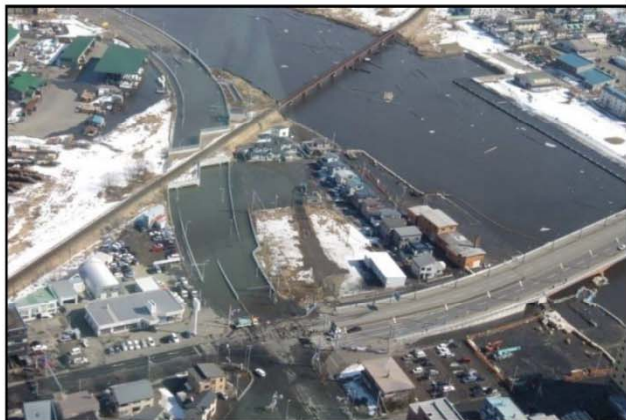
一般国道44号 釧路市 旭アンダーパス(冠水状況)
