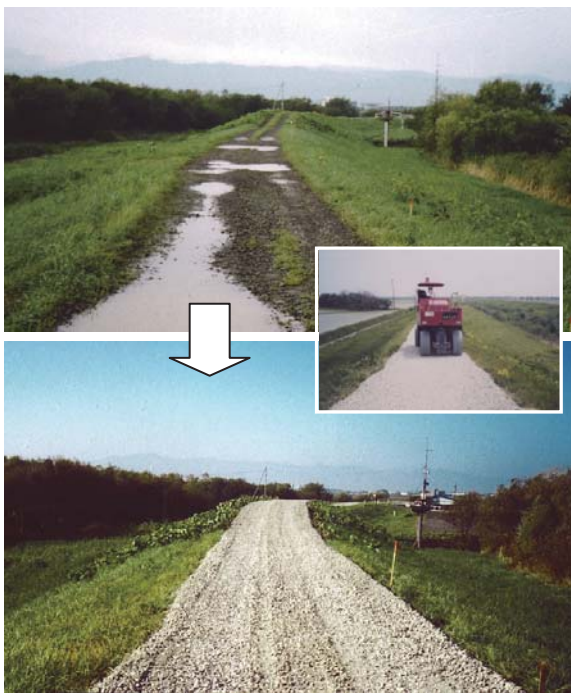
堤防天端の維持管理
