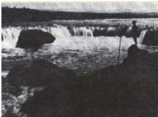
河床の洗掘が著しく、ナイヤガラの滝のように流れる清幌床止の下流 (昭和12年6月)
