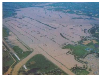
幌向川の破堤による豊幌地区の氾濫状況 (昭和56年8月上旬洪水)
