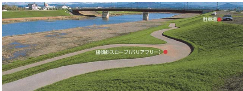
緩傾斜スロープの実施例（旭川市 永山新川）
