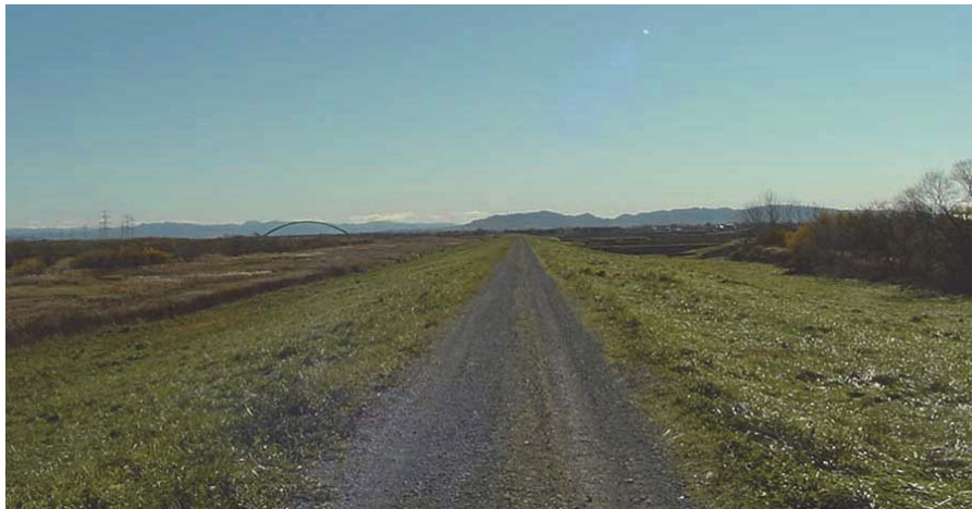
夕張川の緩傾斜堤防
