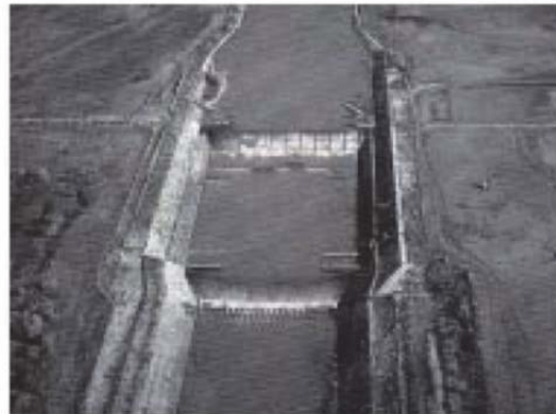
清幌床止（昭和16年完成）
