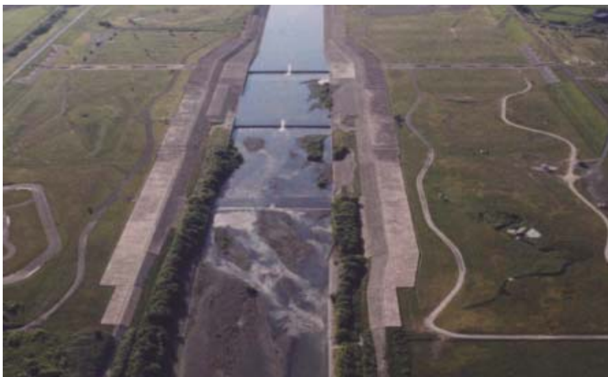
清幌床止（平成 4 年完成）
