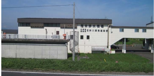
※平常時に撮影 雁来排水機場(最大排水量10m³/s)
