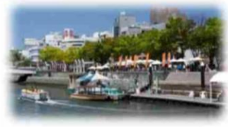
親水護岸の利用 (新町川／徳島市)
