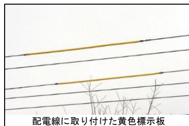
配電線に取り付けた黄色標示板
