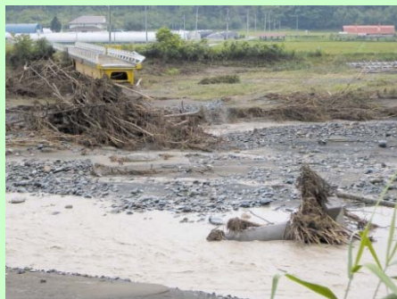
橋の流出状況
