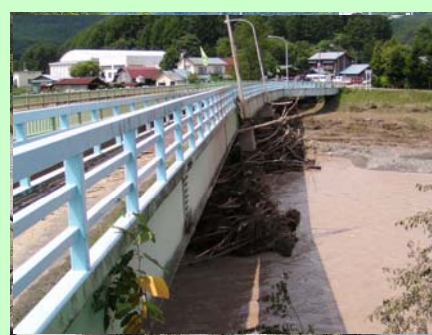
橋に引っかかった流木
